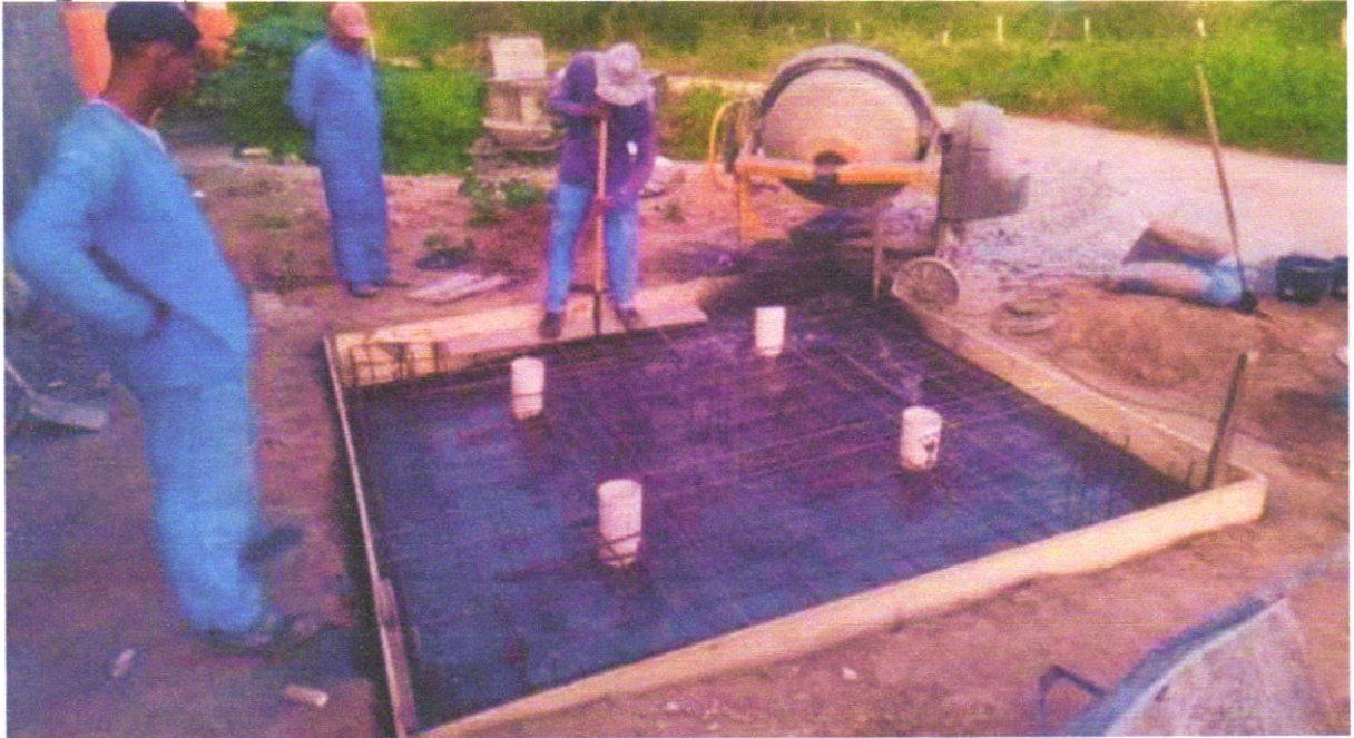
FOTO 25 - ARMAÇÃO DE ESTRUTURAS DE CONCRETO ARMADO, EXCETO VIGAS, PILARES, LAJES E FUNDAMENTOS, UTILIZANDO AÇO CA-50 DE 10,0 MM, 12,5 MM E 25 MM E CONCRETAGEM . AF_ 12/2015.
