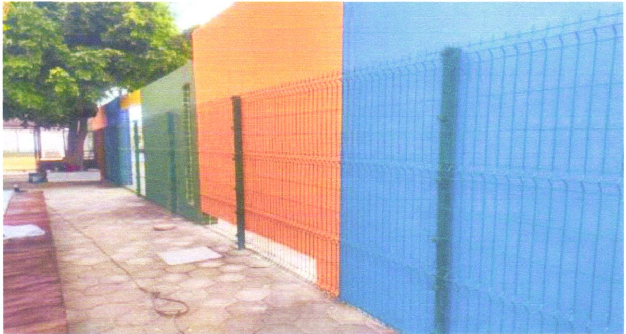
FOTO 04 - GRADIL EM ALUMÍNIO FIXADO EM VÃOS DE JANELAS, FORMADO POR TUBOS DE 3/4". AF_04/2019
