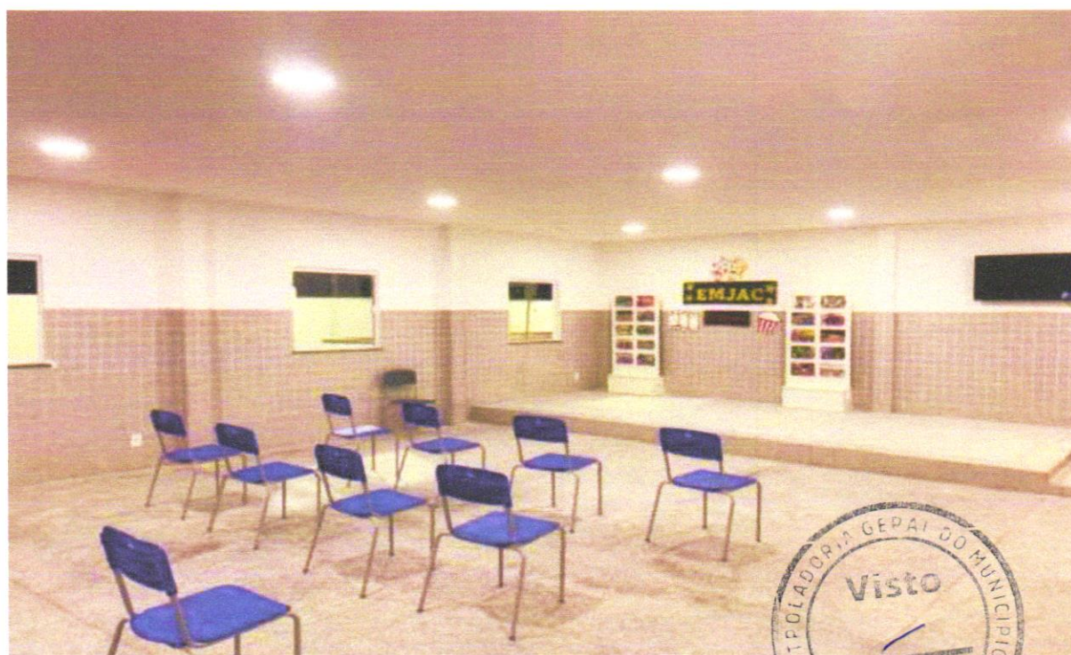
FOTO 16 - FORRO EM PLACAS DE GESSO, PARA AMBIENTES COMERCIAIS. AF_05/2017_P
